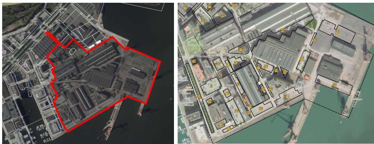
Bild 12.6 a & b: Fastigheten Lundbyvassen 4:6 och parkeringsanläggningar i den södra delen av fastigheten.
